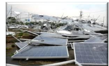
台風により破損したパネル
