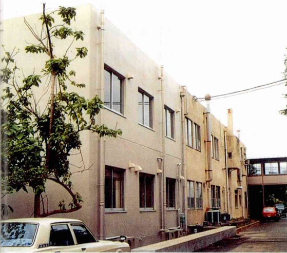
トレーサー棟
