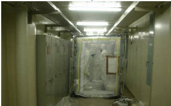
グリーンハウス内での退出作業の状況
