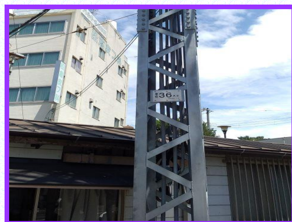
(帝住 36A 柱) ※住吉電車扱室横
